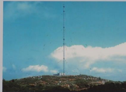
はがね山標準電波送信所 (地上高 200m アンテナ)
