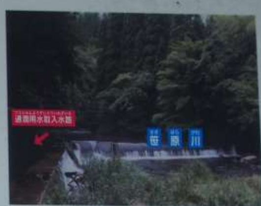
世原川取水口
