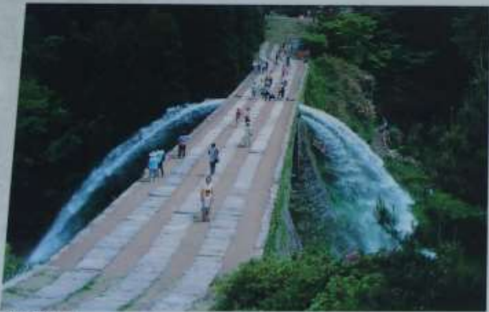
つうじゅんきょう 通潤橋
