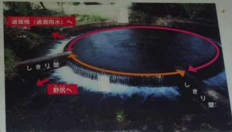
円形分水の内円筒から水があふれ出ている様子
